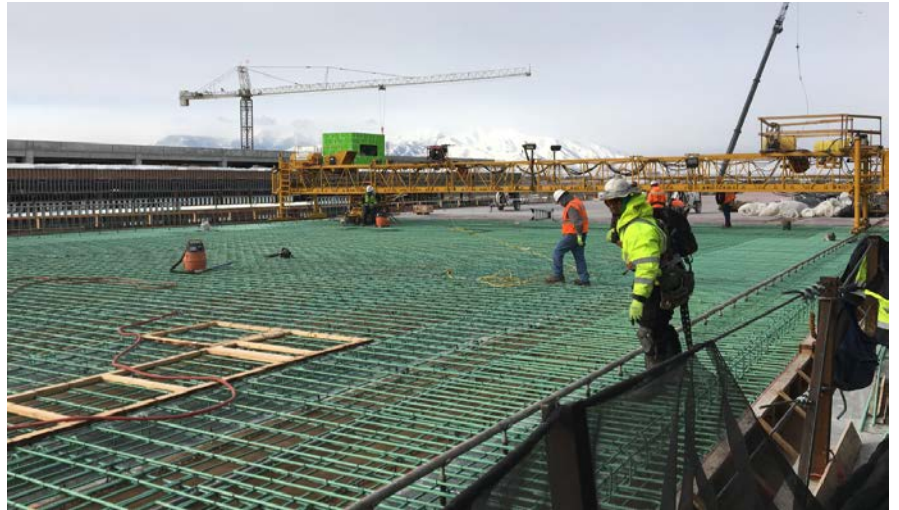
Elevated Roadway Bridge 2 Deck pour prep
